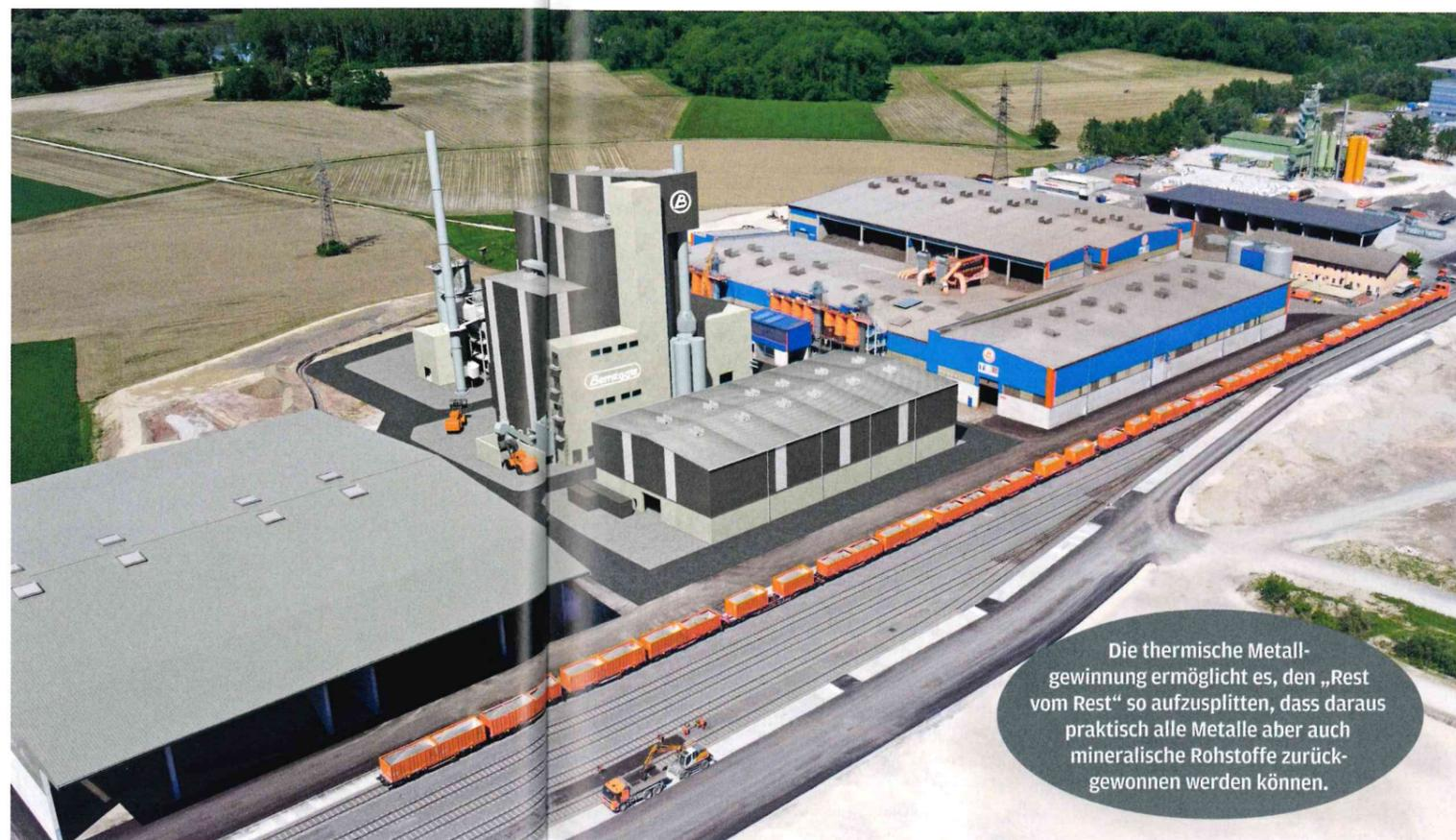
Die thermische Metallgewinnung ermöglicht es, den „Rest vom Rest“ so aufzusplitten, dass daraus praktisch alle Metalle aber auch mineralische Rohstoffe zurückgewonnen werden können.
